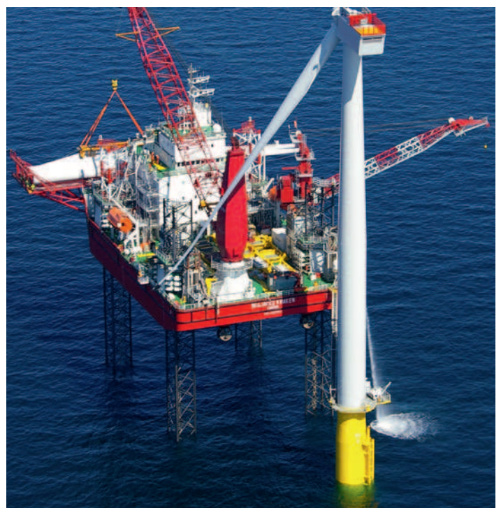
Navire doté de moyens de levage pour l'installation d'éoliennes en mer
