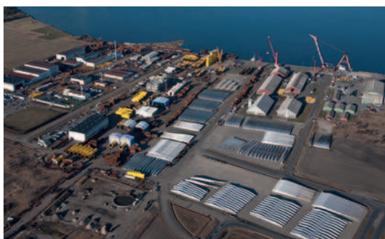
Assemblage et stockage des éoliennes
