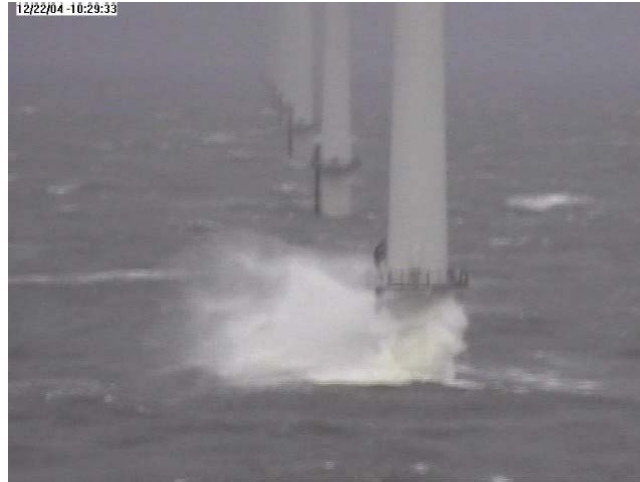
Figure 4-4 : Exemple de run-up sévère sur une éolienne du parc Horns Rev (Vattenfall and DONG Energy)
