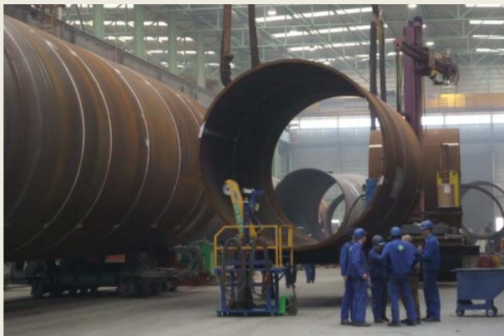
Fabrication des fondations
