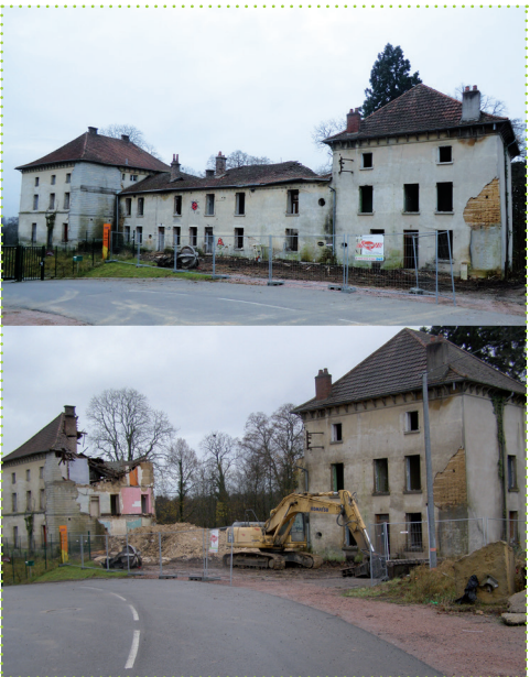
Château d'Avoise avant et pendant déconstruction
