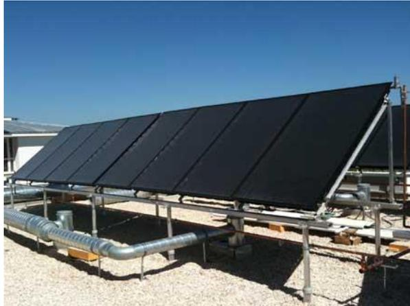
*Exemple de panneaux solaires thermiques en toiture terrasse - tubes sous vide.*
