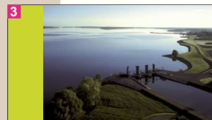
LAC-RÉSEROIR SEINE • Superficie : 2 300 ha • Capacité : 205 M de m 3 • Mise en service : 1966
