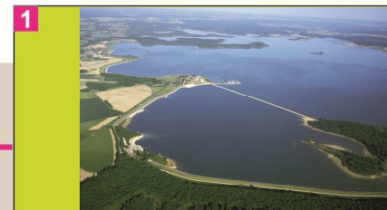
LAC-RÉSEROIR MARNE • Superficie : 4 800 ha • Capacité : 350 M de m 3 • Mise en service : 1974
