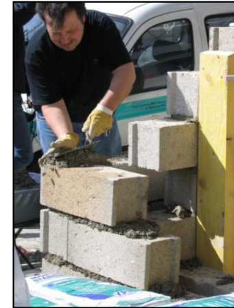
Test de montée d'un mur en parpaings pour protéger un accès à une station de métro (RATP)
