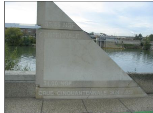
Repère de crue à Alfortville
