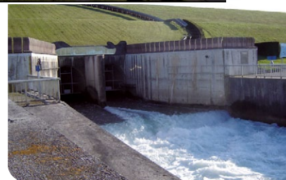
↘ Canal de restitution lac-réservoir Aube.
