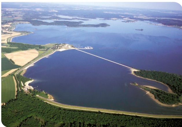
Le lac-réservoir Marne a une capacité de stockage d'environ 350 millions de m³.
