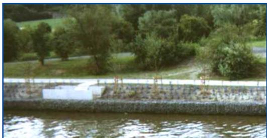
La sécurité de l'ouvrage nécessite une protection de la face côté réserve de surstockage. Un habillage en gabions végétalisés peut être une solution. Cet enrochement crée un nouvel habitat en Bassée pour la flore et la faune.
