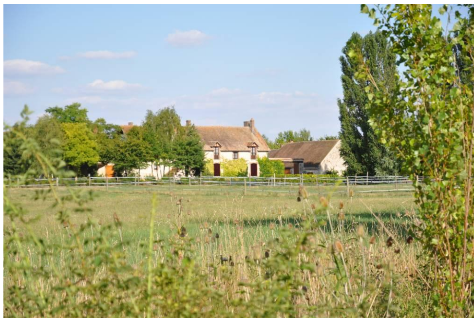
Figure 103 : Photo de la ferme de Roselle – août 2010 (source : Egis)
