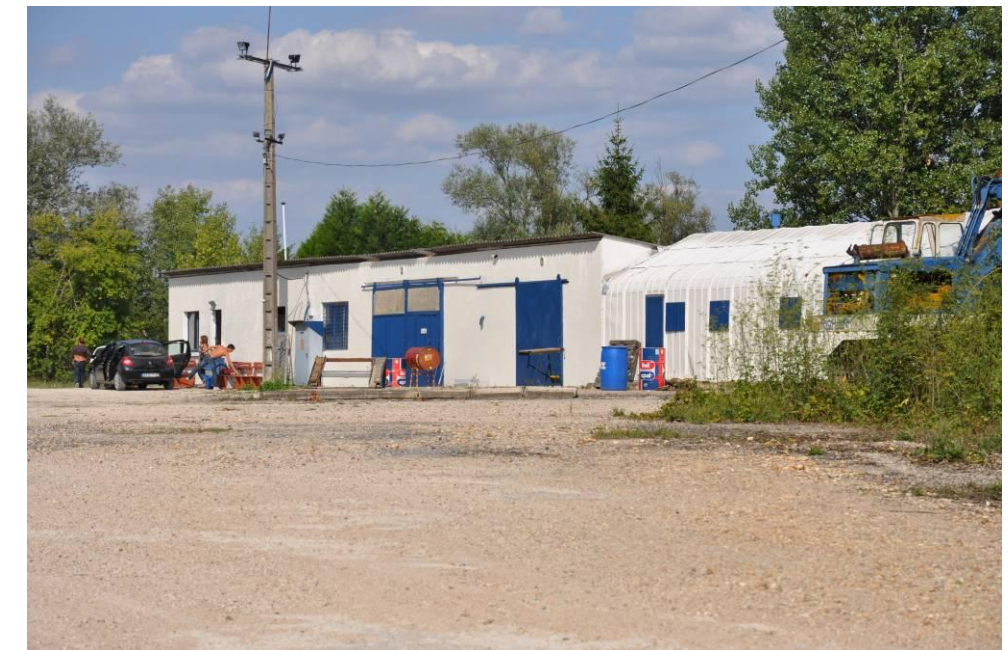
Figure 104 : Photo de l'atelier d'entretien et de réparation de bateaux entre Gravon et La Chapelle – août 2010 (source : Egis)
