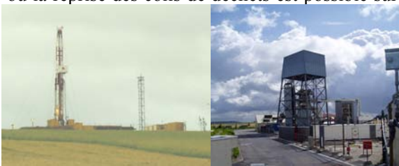
Forages et puits à Bure
