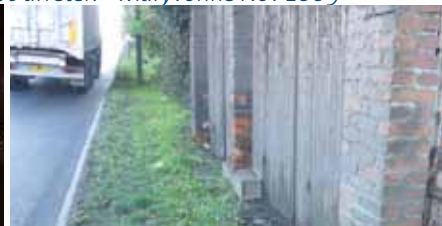
Effets de la pollution sur les murs
