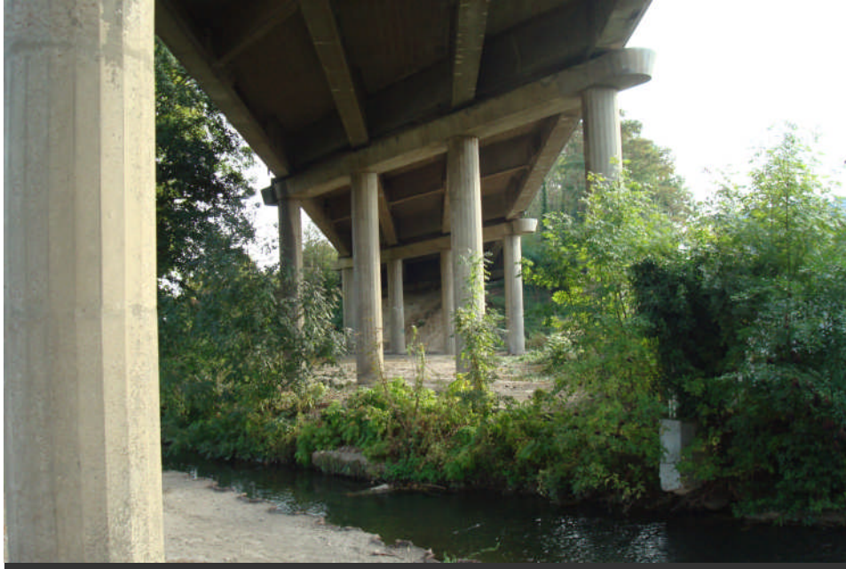
Ouvrage d'art surplombant, à Dreux, la rue Sam Isaacs, et à élargir d'une voie,
