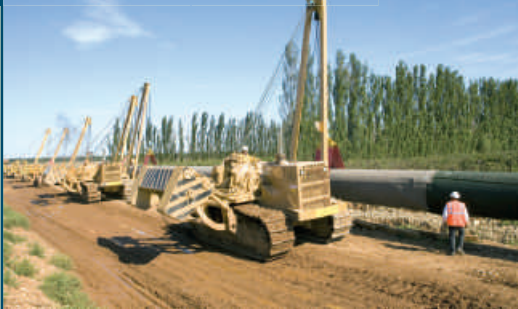
Préparation de la mise en fouille d'une canalisation
