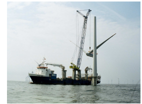
Barge d'installation des éoliennes
