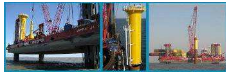
Barges d'installations des fondations
