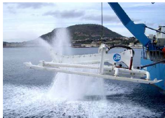
Charre creusant le sillon pour ensouillage (CDV)
