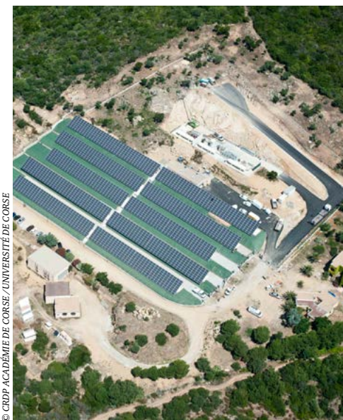
La plate-forme MYRTE est un site pilote qui met en œuvre une centrale photovoltaïque de 560 kWc pour la production et le stockage d'hydrogène. En cours d'installation à Ajaccio, elle est soutenue par l'Université de Corse Pasquale-Paoli, Areva et le CEA.
