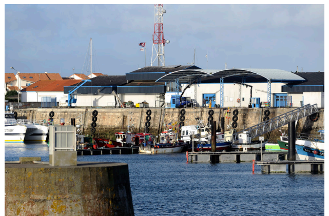
Port de l'Herbaudière
