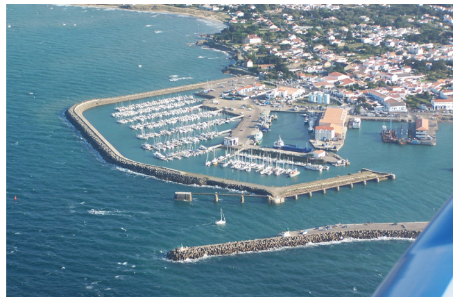
Port-Joinville accueillerait la base de maintenance principale du parc éolien
