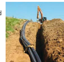
Chantier d'une liaison simple souterraine en pleine terre
