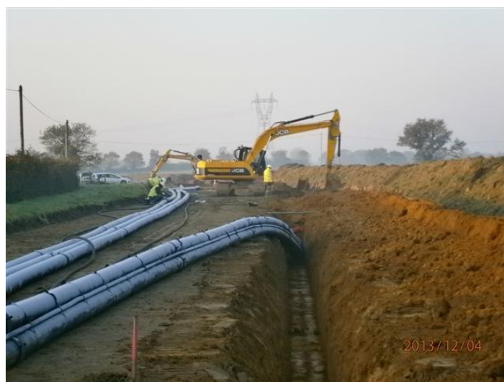
Figure 5 : Illustration de pose en PEHD d'une liaison souterraine à deux circuits
