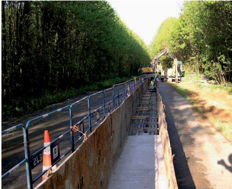
Pose en demi-chaussée
