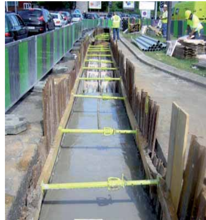
Tranchée et béton sous chaussée
