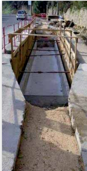
Chambre de jonction
