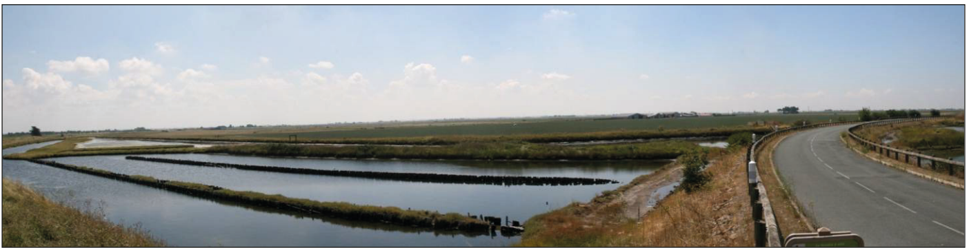
Illustration 4 : les canaux qui irriguent le Marais Breton (source : Abies).
