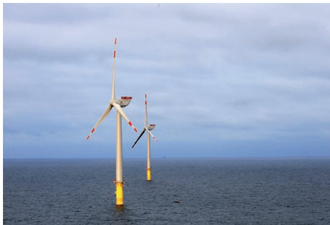
Eolienne AREVA M5000 Parc alpha ventus, mer du Nord
