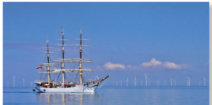
Parc éolien de Nysted, Danemark
