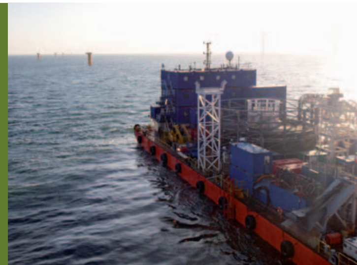
/// Installation des câbles dans le parc de Lincs offshore wind farm
