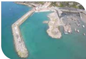
LE PORT D'ERQUY PENDANT LES TRAVAUX
