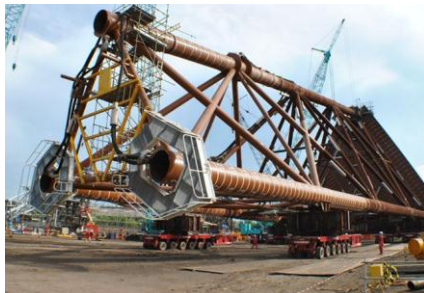
Voirie lourde pour le transit
