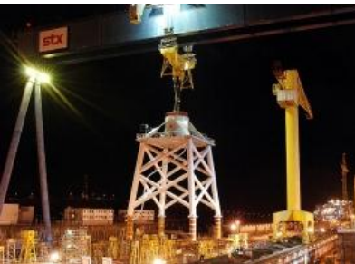
Pont roulant de forte capacité
