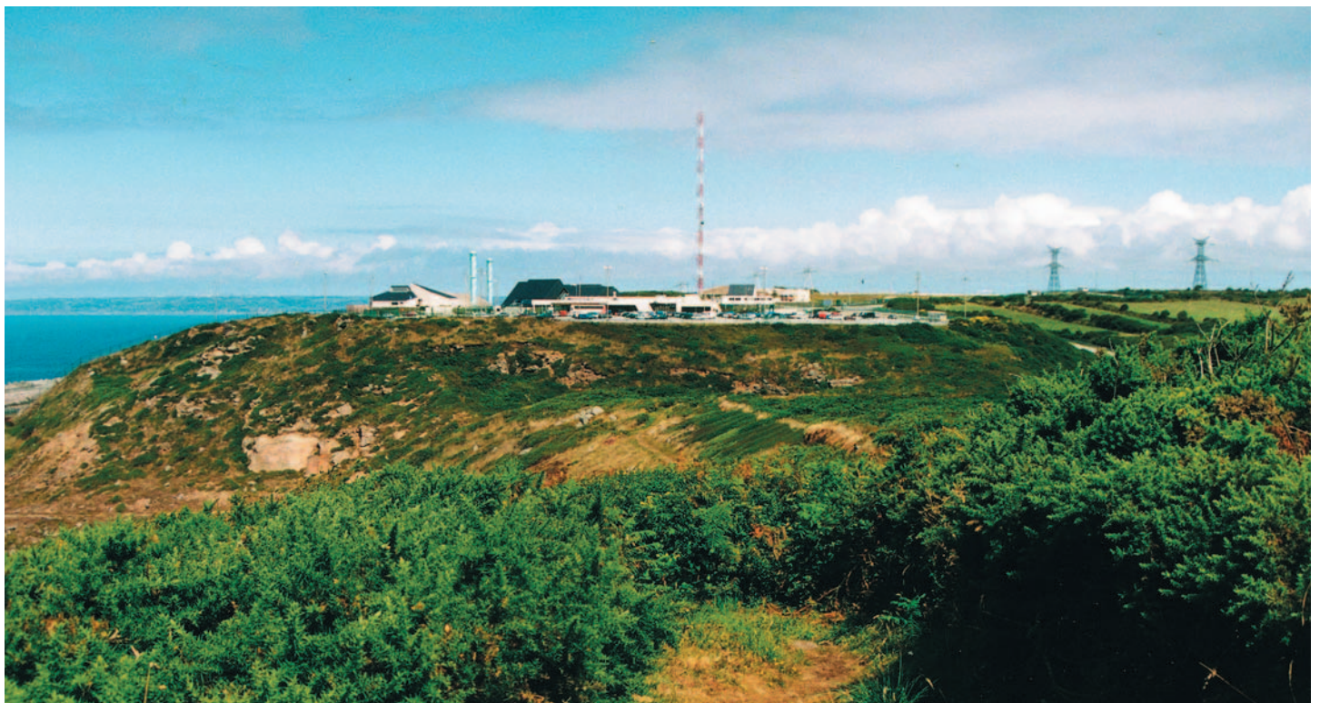
Le site de Flamanville abrite déjà deux tranches de production nucléaire d'électricité
