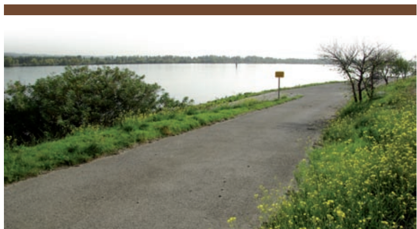
⚡ Passage du gazoduc existant sous le Rhône
