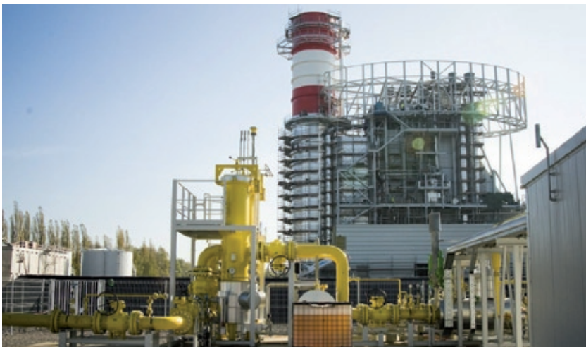
⚡ Centrale à Cycle Combiné Gaz de Powéo - Pont sur Sambre
