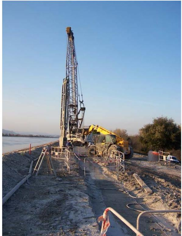
**Photo 2 : Réalisation d'une paroi d'étanchéité dans le corps de digue (canal d'aménée de Donzère-Mondragon)**
