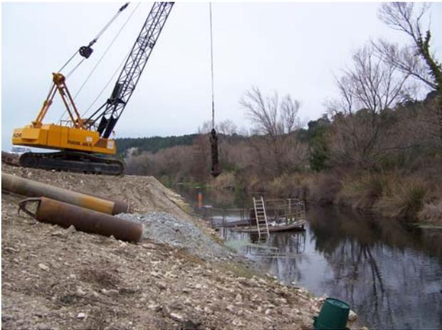
**Photo 1 : Mise en œuvre de forages de décompression dans le contre canal à Villeneuve lès Avignon**
