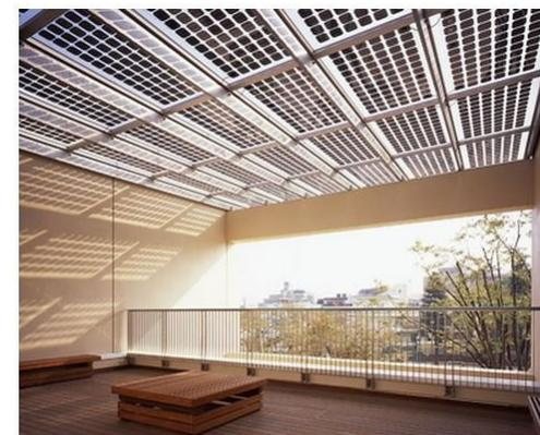
FIGURE 8 : PHOTOVOLTAÏQUE : INTEGRATION AUX VITRAGES
