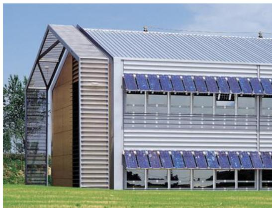
FIGURE 9 : PHOTOVOLTAÏQUE : INTEGRATION AUX BRISE-SOLEILS
