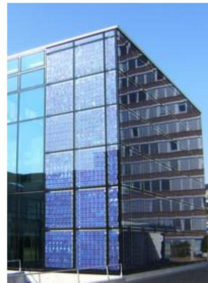
FIGURE 7 : PHOTOVOLTAÏQUE : POSE EN FAÇADE
