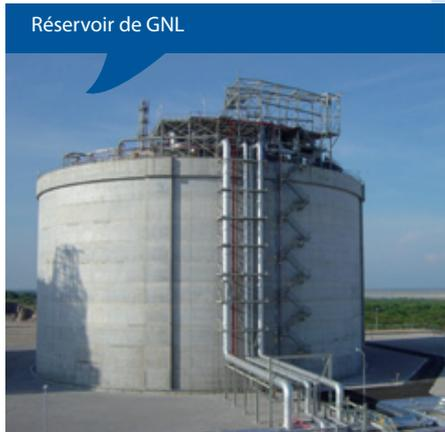
les lieux de consommation par navire méthanier<sup>2</sup>. Ces navires sont accueillis dans un terminal méthanier. Le GNL\* est stocké dans des réservoirs cryogéniques\*, avant d'être regazéifié afin d'être envoyé dans le réseau de transport de gaz naturel à destination du client final (voir ci-contre : la chaîne du GNL).
