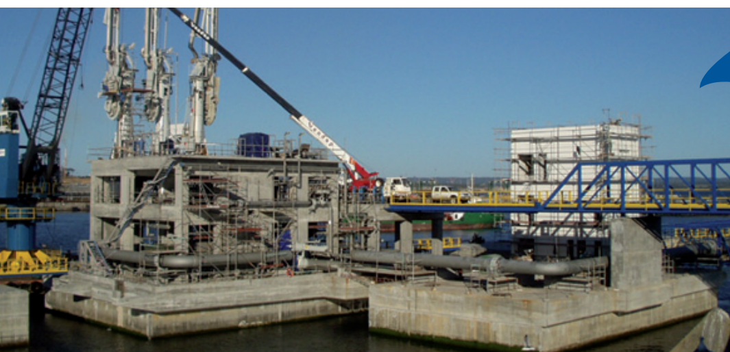
Construction de la jetée d'un terminal méthanier
