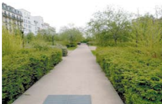
Aménagement d'une tranchée couverte en milieu urbain
