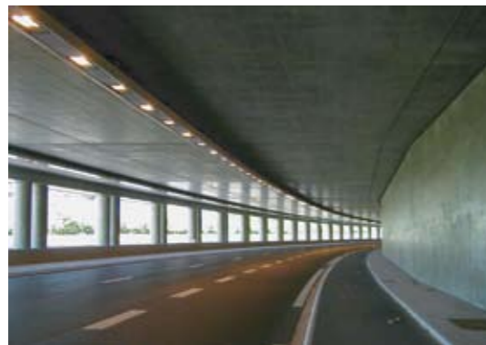
Section d'autoroute semi-couverte
