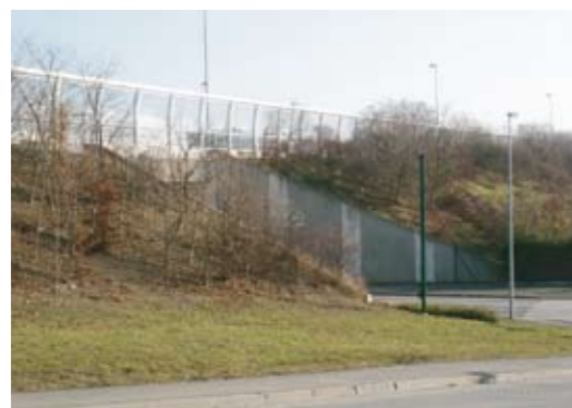
Remblais avec protection phoniques
