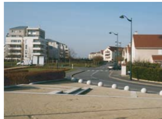
Aménagement d'une tranchée couverte en milieu urbain
