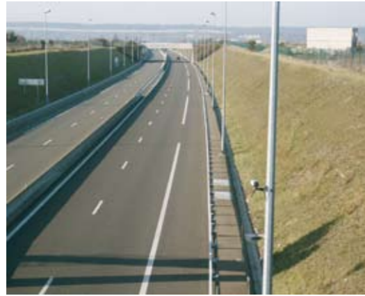
Section d'autoroute en déblai
