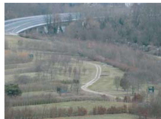
Aménagement d'une tranchée couverte en milieu rural
