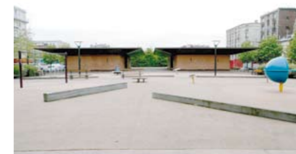
Locaux de ventilation des tunnels
