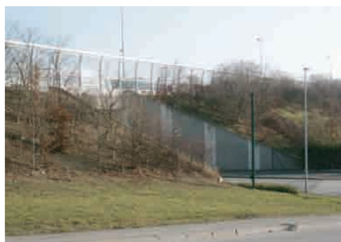
Remblais avec protection phoniques
