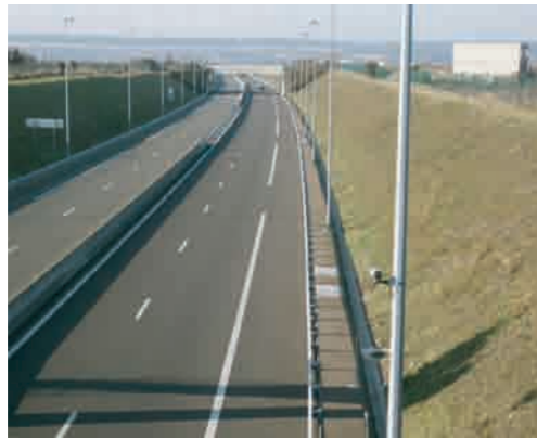
Section d'autoroute en déblai
