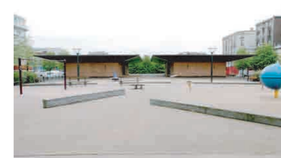
Locaux de ventilation des tunnels
