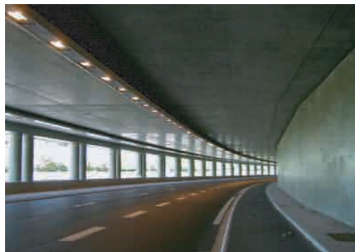
Section d'autoroute semi-couverte
