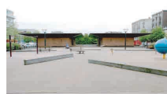
Locaux de ventilation des tunnels
