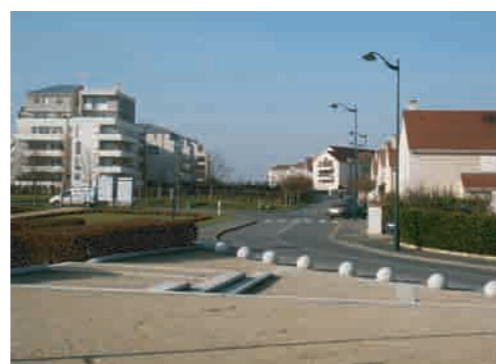
Aménagement d'une tranchée couverte en milieu urbain
