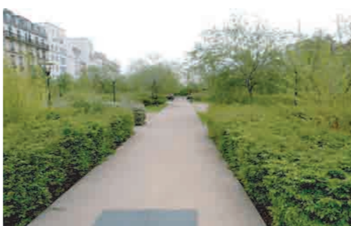
Aménagement d'une tranchée couverte en milieu urbain
