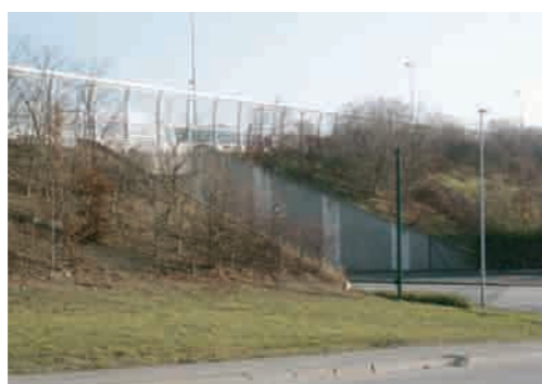
Remblais avec protection phoniques
