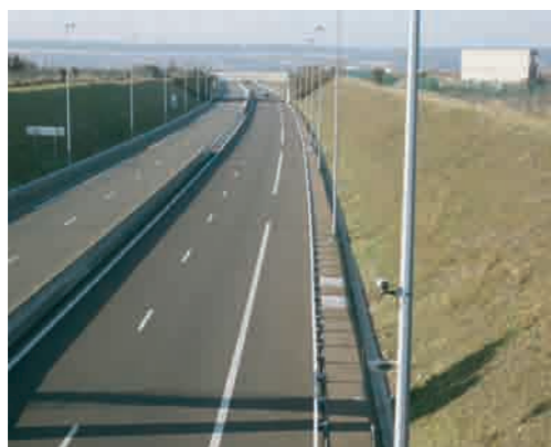
Section d'autoroute en déblai
