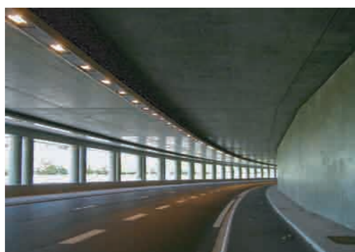
Section d'autoroute semi-couverte
