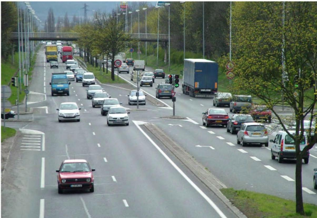
Le carrefour avec le boulevard Charles De Gaulle est à l'évidence mal calé par rapport aux carrefours aval et amont et pour cause, le temps de vert alloué sur la RN 184 est limité par son fonctionnement à 4 temps, alors que les carrefours amont et aval fonctionnent respectivement en 2 et 3 temps. Quelle que soit la charge de trafic, ou quelle que soit l'heure de la journée, ce carrefour engendre des files d'attente, en particulier dans le sens sud / nord.
