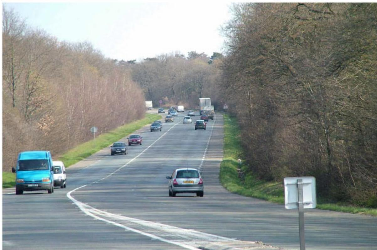
A l'extrémité de cette ligne droite, la DDE suite à des accidents fréquents dont le dernier fut mortel, a modifié son marquage au sol pour ne laisser de part et d'autre de la chaussée qu'une seule file par sens. La sécurité a été rétablie à ce prix. Il est regrettable que la DDE n'ait pas trouvé opportun de supprimer les secondes files au-delà du seul virage.
