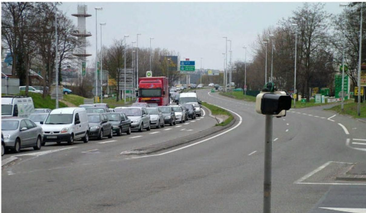
La pollution ainsi dégagée par ces véhicules à l'arrêt peut être une des sources du mécontentement des riverains. La reprise de la géométrie du carrefour, avec par exemple, un rond-point percé, aurait permis d'en simplifier sa gestion et de le caler en coordination. Aux heures de pointe, ce phénomène est aggravé par les difficultés d'écoulement du trafic rencontrées sur l'échangeur A15/ RN184.
