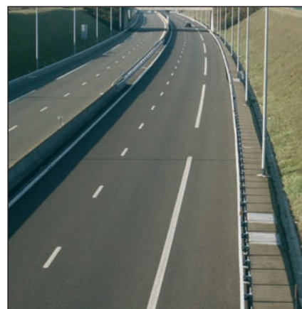
Section de l'autoroute A14 en déblai, Carrières-sur-Seine.
