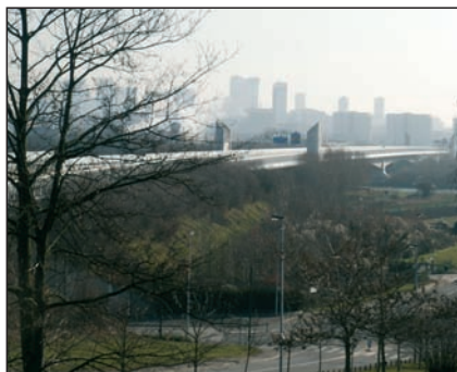
Exemple de viaduc sur l'A14, à Carrières-sur-Seine.
