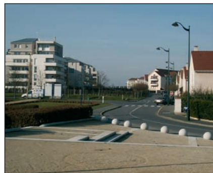
Exemple de tranchée couverte en milieu urbain, sur l'A14 à Carrières-sur-Seine.
