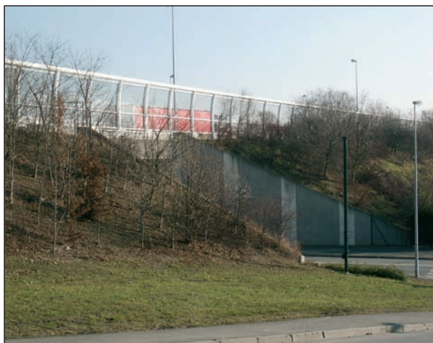
Exemple de remblai avec écran acoustique sur l'autoroute A14, à Carrières-sur-Seine.
