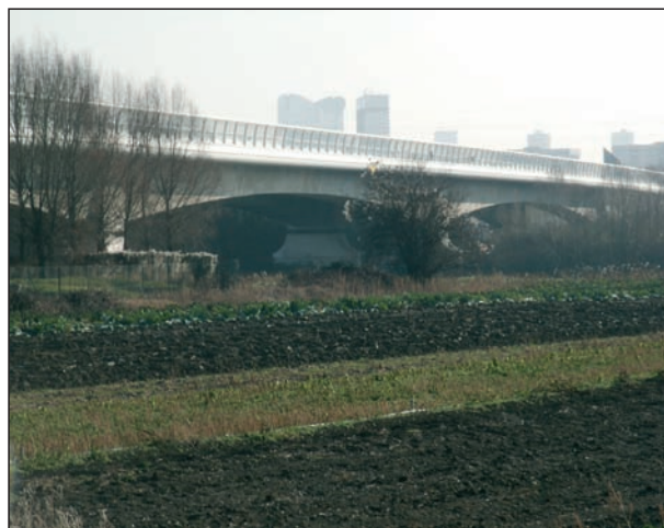
Exemple de viaduc avec écran acoustique sur l'autoroute A14, à Carrières-sur-Seine.
