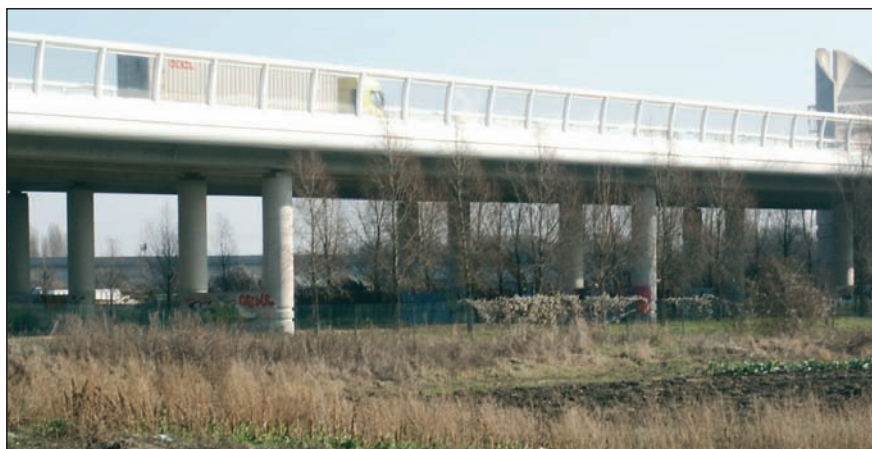
Exemple de viaduc en zone inondable sur l'autoroute A14, à Carrières-sur-Seine.
