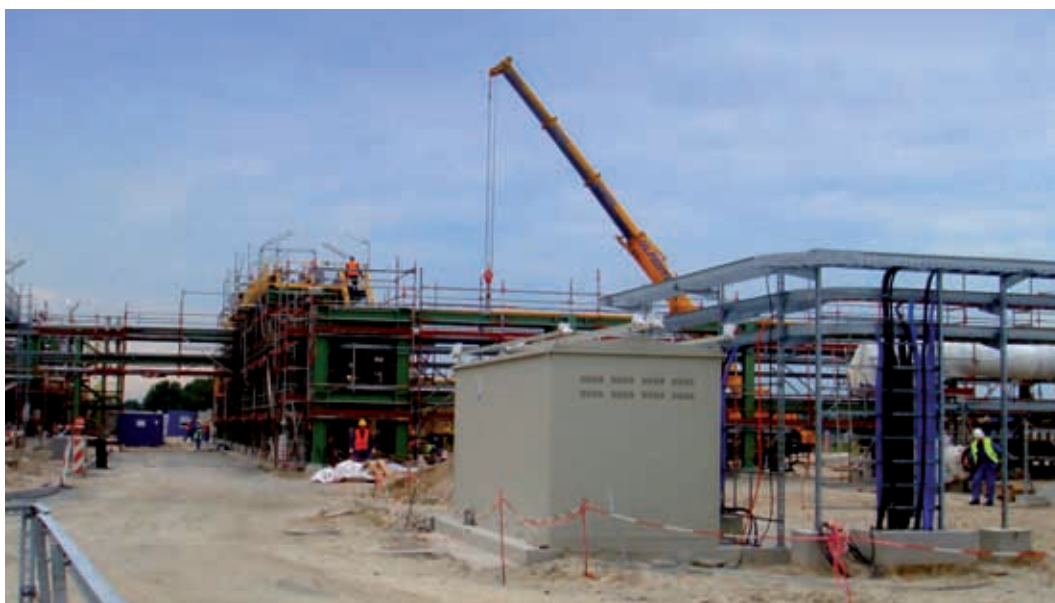
Site d'Etzel en construction (© EDF)
