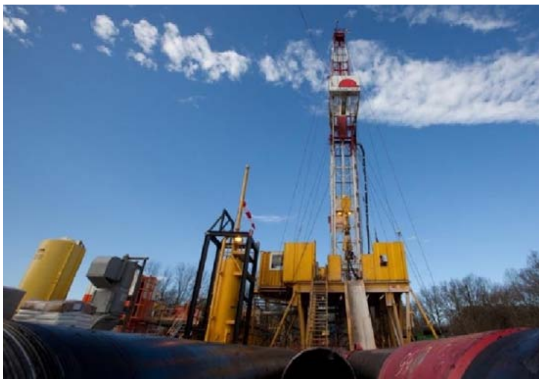
Forage SDL1 (© EDF)
