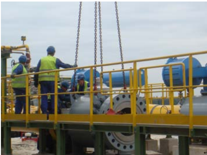
Site d'Etzel en construction (© EDF)
