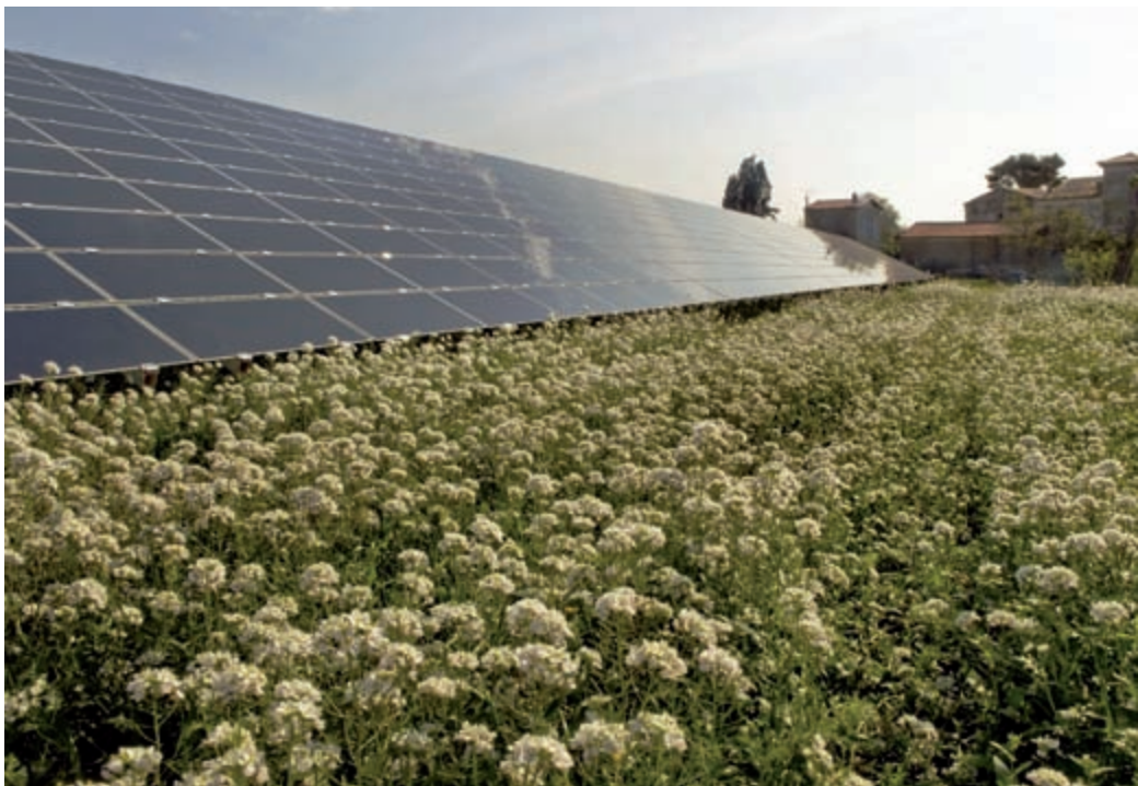
Centrale photovoltaïque du Gabardan (© EDF - MIGNAUX LAURENT - MEEDDAT)
