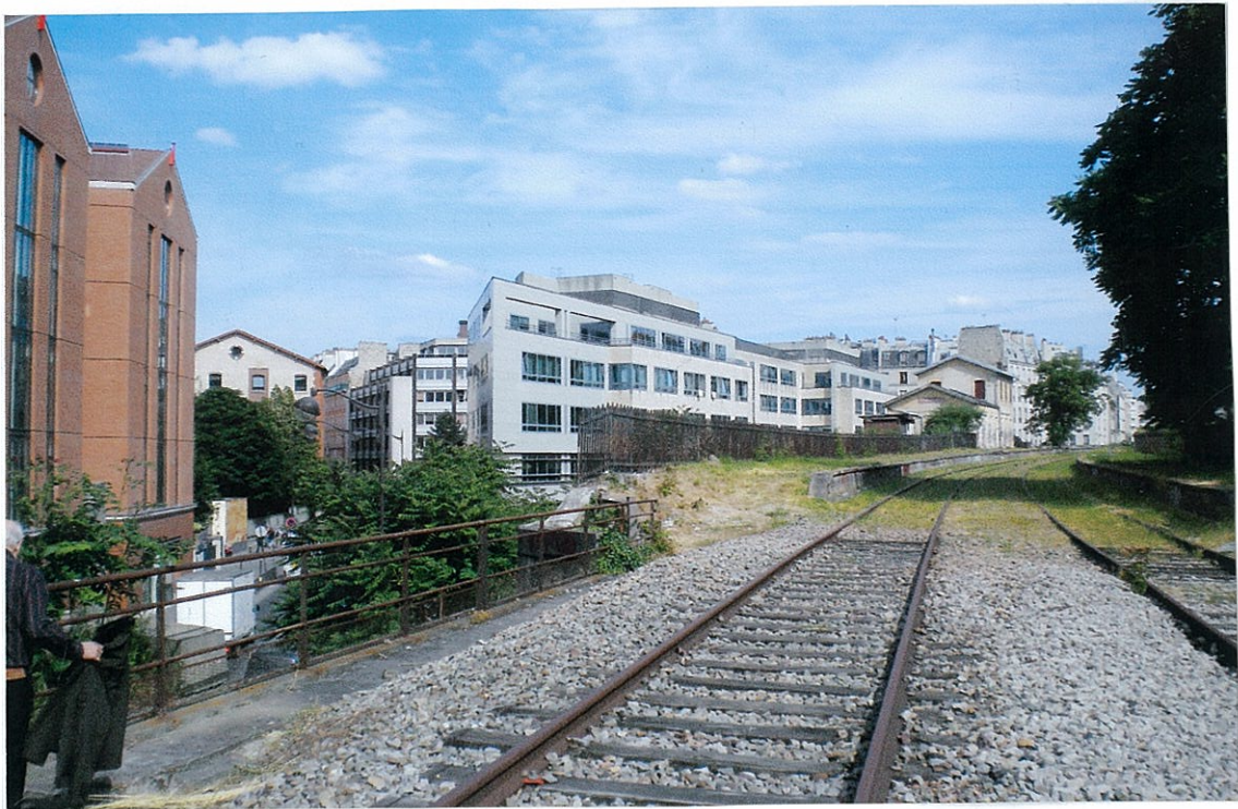
Une nouvelle desserte pour la cité des sciences et de l'industrie : la station Corentin Cariou avec un accès au parc d'activités Pont de Flandre, rue de Cambrai
