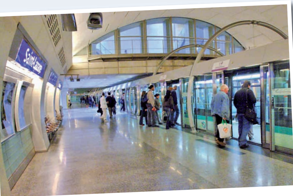
Futur accès au pôle d'échanges Chatelet-Les Halles
