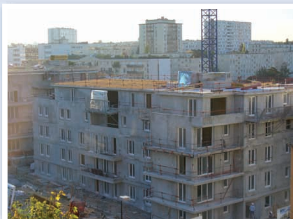
Exemple de la densification du « Plateau-18 Juin 1940 » : construction d'immeubles de logements collectifs Résidence Corneille en construction et les Mazurières
