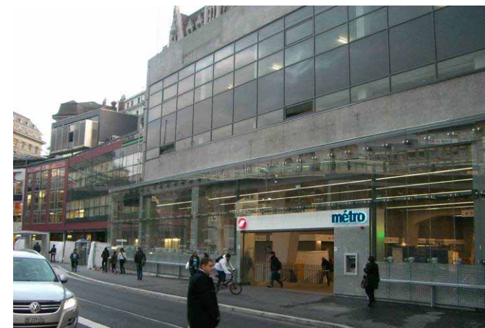
Bâtiment station de métro, Lausanne Flon
